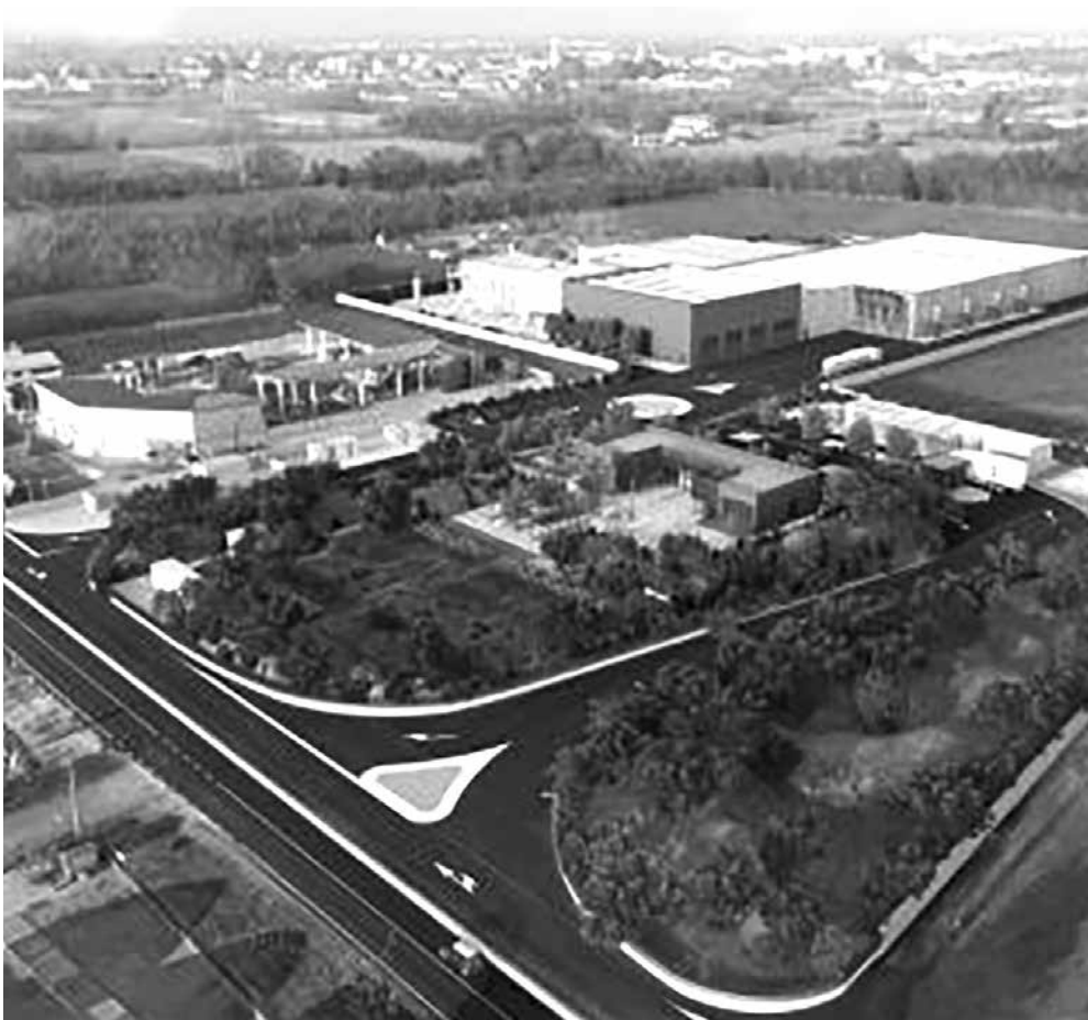
Vista aerea dell’impianto
