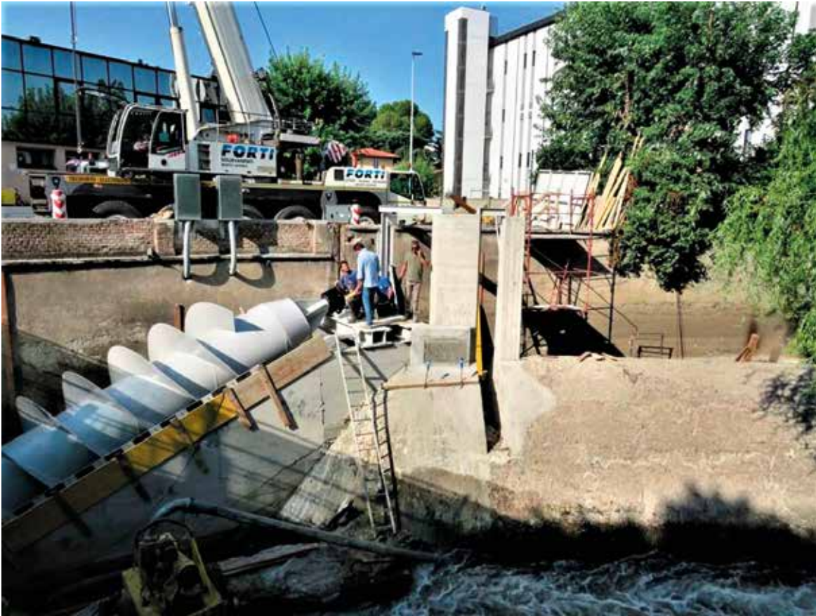
Posizionamento della coclea sulla diga Mazzocchi
